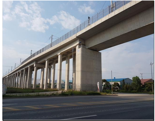
교량 측면 전경
